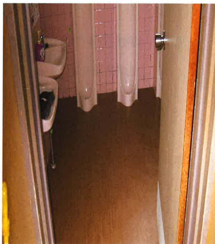
⑦遊戯室のトイレの床を改修
