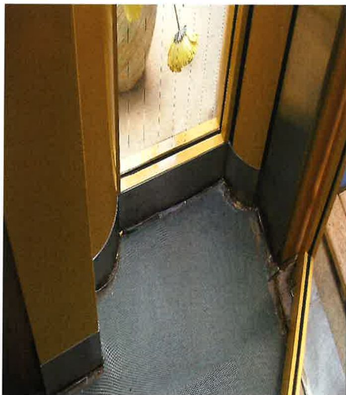
⑥遊戯室の腐食部を改修
